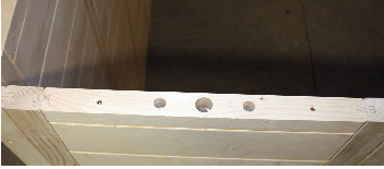
Elektroelement links - Abluft rechts hinten.
