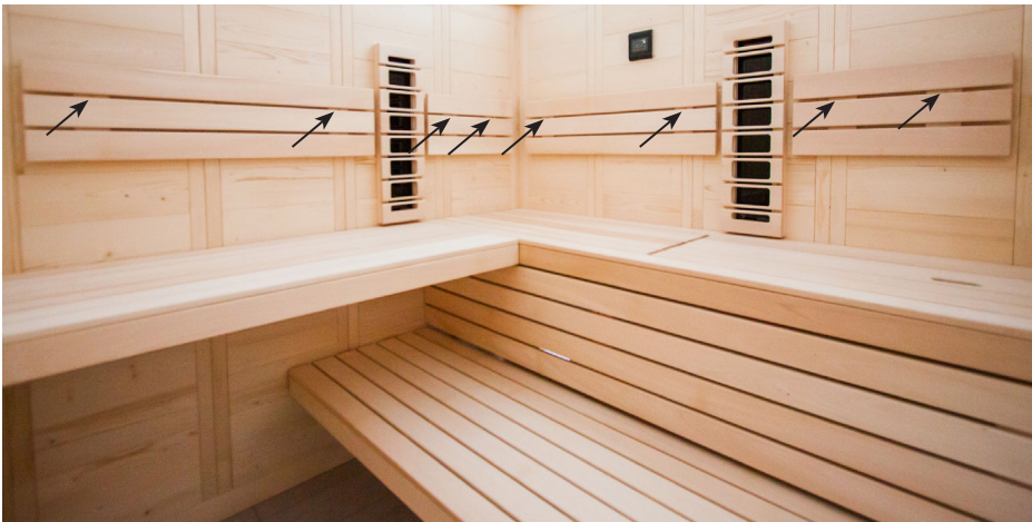
Bohrer 3mm, 8 Stk. Schrauben 4 x 70 mm
