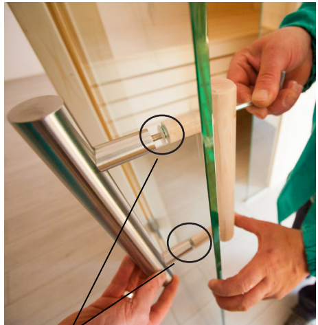
Kunststoff Beilagscheibe bei Niro-Griff beilegen
