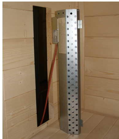
Abb. 2: Position Anschlusskasten
