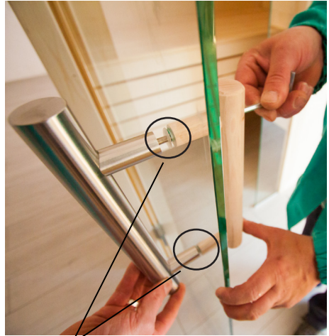
Applicare rondelle di plastica nelle maniglie Nirosta
