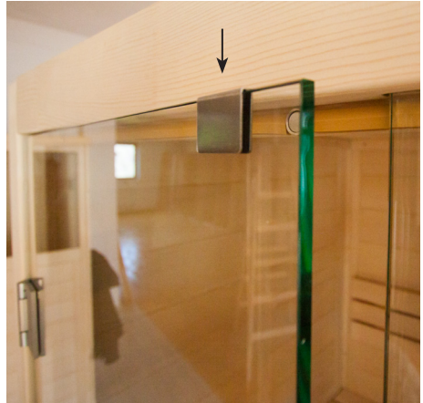
Applicare rondelle di plastica nelle maniglie Nirosta
